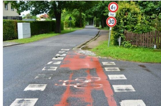
Blind endender Radweg im Wasserwerksweg, OT Klausdorf
